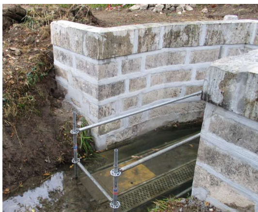
Figure 12 : Vue de l'opération de batardage d'un ouvrage de régulation du canal d'Orléans (45)
