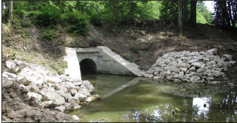
Figure 20 : Exemple de comblement de zones affouillées par enrochements
