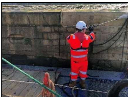
Figure 13 : Procédure de nettoyage des bajoyers
